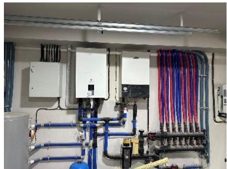
Նկ.4. Առանձնատան ջերմապոմպային տեղակայանքով ջեռուցման համակարգ
