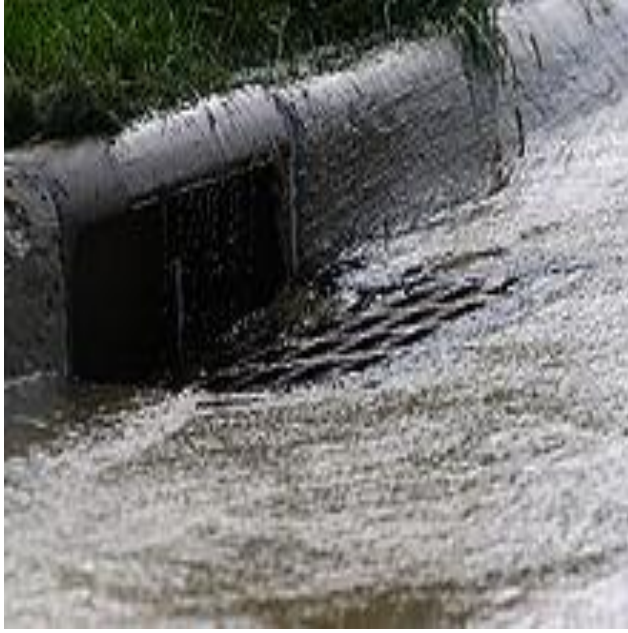
Նկար 22. Ամերիկյան փակ ջրհավաք հոր: American-style curbside storm drain receiving urban runoff
