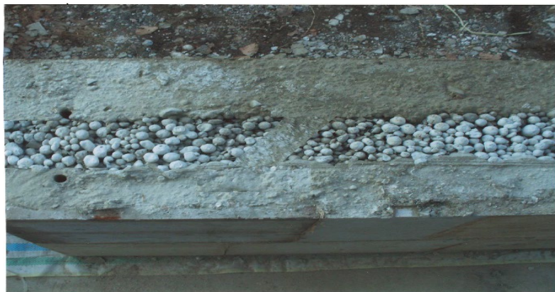
Նկ. 3. Եռաշերտ պատ, բջջային ապակուց հատիկանյութի հենքի վրա ջերմամեկուսիչ թեք կողավոր սալերով
