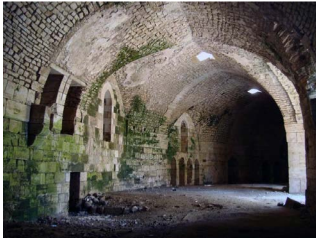
Րիս.1. Каменные своды большого зала крепости Аль-Хосн, разрушающиеся в результате просачивания воды
