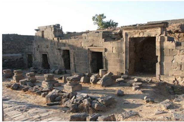
Րիս.4. Разрушение каменной кладки вследствие осадки основания. Босра
